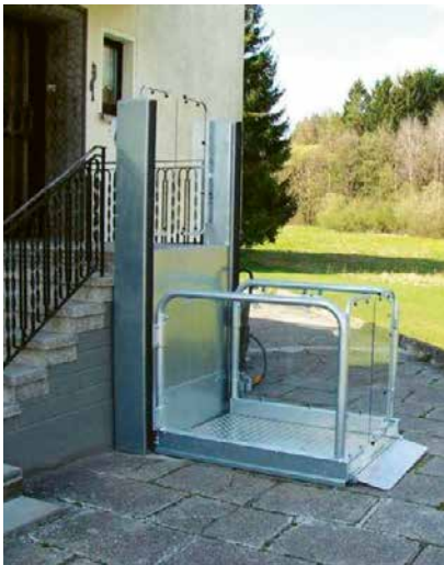
Überwindung des vorhandenen Niveauunterschieds durch einen Hebelift Privates Einfamilienhaus
