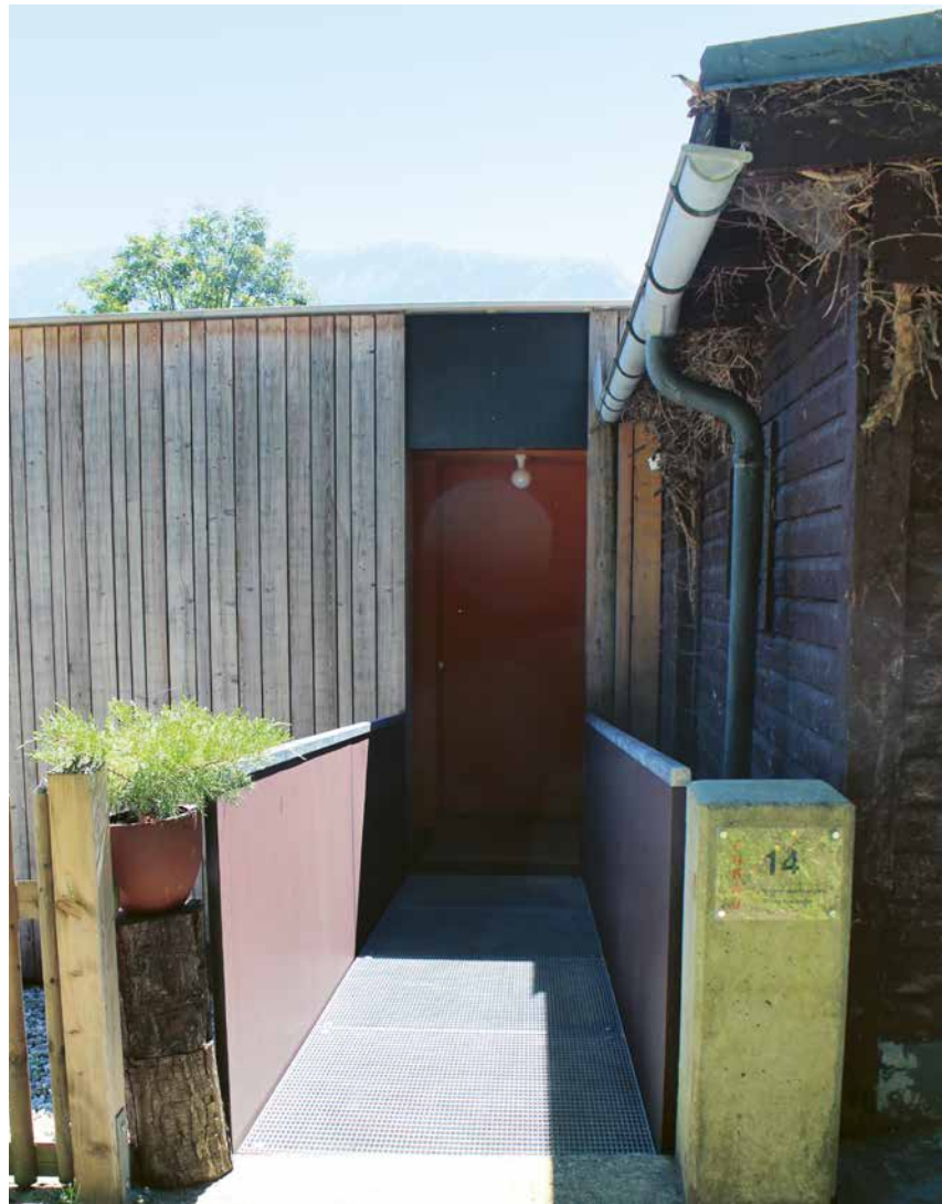
Durch die Errichtung einer Brücke kann der am Hang gelegene Anbau dieses Gebäudes barrierefrei erschlossen werden. Da das Gebäude in einer schnee-reichen Region liegt, wurde ein rutschfestes Gitter als Bodenbelag gewählt. So bleibt auch im Winter nur wenig Schnee liegen, der sich einfach abkehren lässt. ♦ Kiefersfelden, privates Einfamilienhaus
