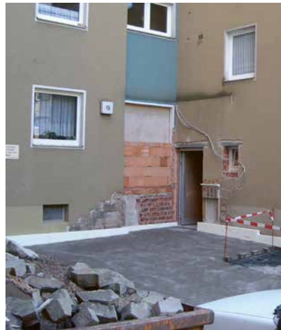
Umbau Abbruch der Treppe und Verlegung des Eingangs auf Zugangsniveau.
