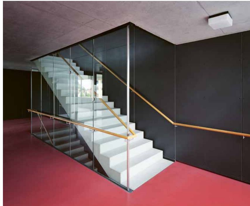
Treppe mit beidseitigen, griffsicher ausgebildeten Handläufen und Weiterführung des Handlaufs. Da die Treppe seitlich von der Verglasung begrenzt wird, ist eine seitliche Aufkantung gegen Abrutschen nicht notwendig. Die kontrastierende Farbgestaltung ermöglicht es, Treppe und Handlauf gut zu erkennen. Markierungen an der ersten und letzten Stufenvorderkante würden die Erkennbarkeit noch weiter verbessern.
