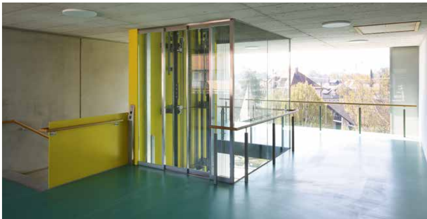
Die farblich kontrastierende Gestaltung ermöglicht es für Menschen mit Seheinschränkungen die Treppe gut zu erkennen.
