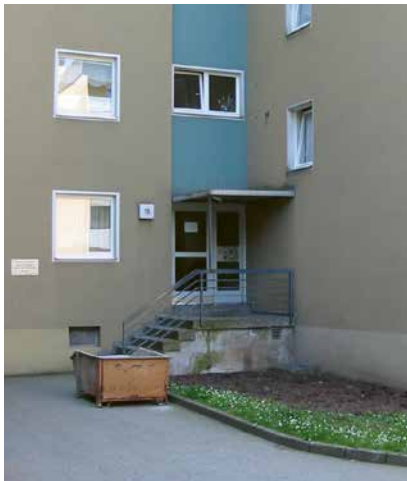
Bestand Eine halbe Geschossebene muss überwunden werden.
