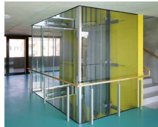
Der Handlauf wird um den Aufzug herum weitergeführt.
