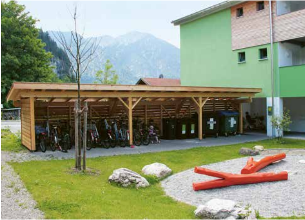
Überdachte und gut erreichbare Fahrradstellplätze in Eingangsnähe erleichtern den Bewohnern die Nutzbarkeit. 📍 Oberammergau, Am Rainenbichl
