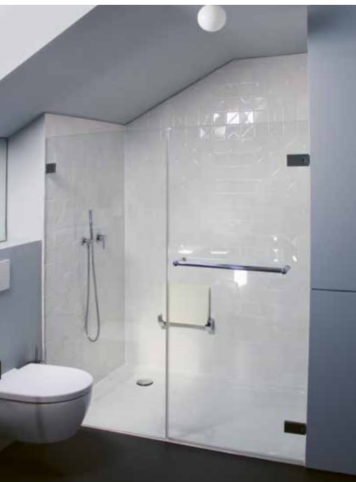
Bodengleiche Duschen bieten in jedem Alter erhöhten Komfort und können durch Detaillösungen bautechnisch sicher ausgeführt werden. Kiefersfelden, priv. Einfamilienhaus
