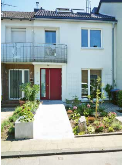
Überwindung des vorhandenen Niveauunterschieds durch eine Rampe ♦ Aachen, privates Einfamilienhaus
