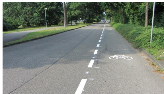
Abbildung 4: Einseitiger Schutzstreifen in der Straße Am Wald in Karlsruhe 2016. (Quelle: Stadt Karlsruhe)
