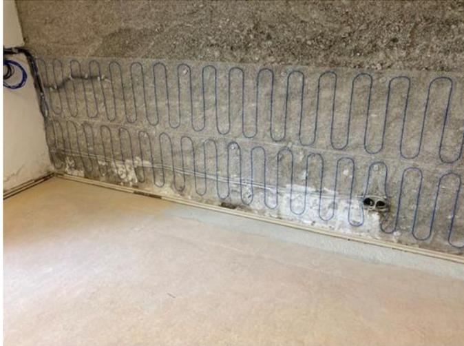
Im Gebäude wurde die betroffene Wand mit einer elektrischen Wandheizung versehen, um diese gegen Erdreich zu trocknen und auch dauerhaft trocken zu halten
