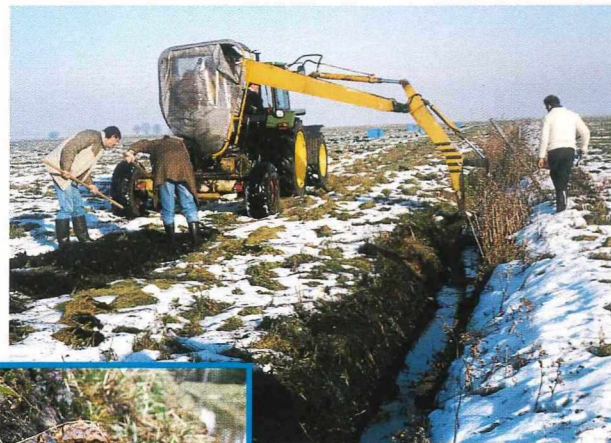
Grabenräumung mit Bagger
