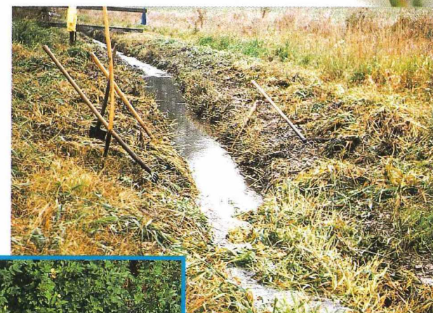
Handräumung eines Grabens
