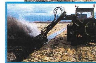
Grabenfräse im Einsatz
