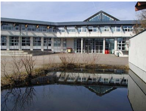
Zweckverband Staatl. Realschule Vaterstetten mit Einfach- und Zweifachturnhalle
