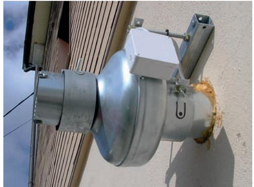
*Ein außen liegender Ventilator erzeugt einen leichten Unterdruck unter der Bodenplatte.*
