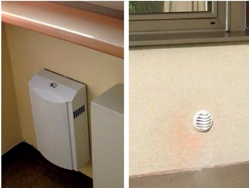
*Kontrollierte Frischluftzufuhr erzeugt leichten Überdruck im Raum/Gebäude (innen und außen).*
