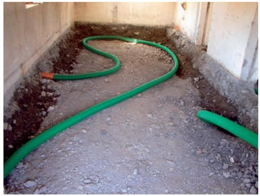
*Erneuerung des Fußbodenaufbaues: Einbau einer Radondrainage.*
