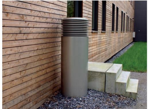
*Ansaugöffnung für mechanische Zuluftanlage.*
