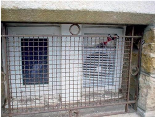
Mit einem kleinen Ventilator wird im Kellergeschoß oder Kriechkeller ein Unterdruck gegenüber dem Wohnbereich erzeugt.
