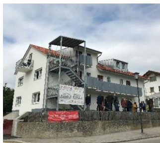
Zweites Objekt in Moosach 2020
