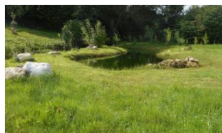
Retentionsausgleichsmulde eines Bauvorhabens im Überschwemmungsgebiet
